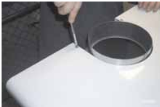
Рис. 3 - Выкрутите два винта - самореза 2, удерживающих крышку котла.
